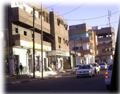
الصورة (6) التلوث البصري الناجم من تشابك اسلاك الكهرباء
