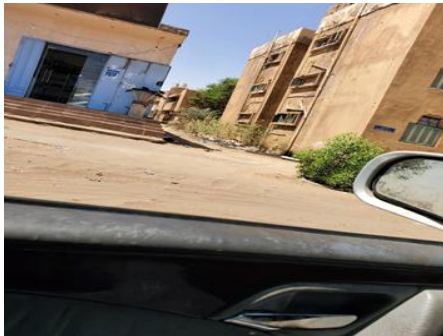
الصور (20) التلوث البصري الناجم من تردي وسوء واجهات المباني
