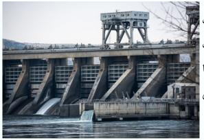
تتكون الطاقة الكهرومائية من المياه المتدفقة، وتقع معظم محطات الطاقة الكهرومائية على سدود كبيرة للتحكم في تدفق النهر. حيث تقوم السدود بحسر مياه النهر وتشكل بحيرة أو خزانًا اصطناعيًا ويتم دفع كَمّيَّة محددة من المياه عبر الأنفاق في السد وعندما تتدفق المياه عبر الأنفاق فإنها تدير عنفات ضخمة تولد الكهرباء.
